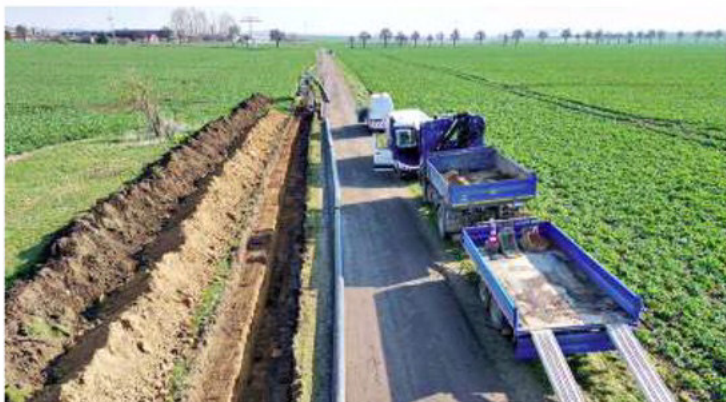
Der Zwag hat inzwischen den Bauabschnitt zwei der Fernwassertrasse von Mücheln zum Hochbehälter Krumpa begonnen.
