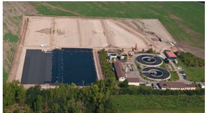
Klärschlammvererdungsanlage
